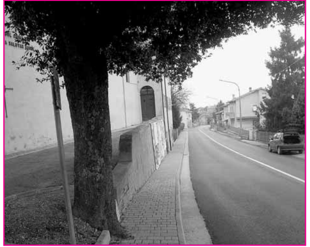
Nuovo marciapiede chiesa Tornazzano
