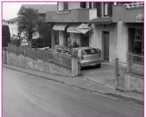
Nuovo marciapiede via Grazie
